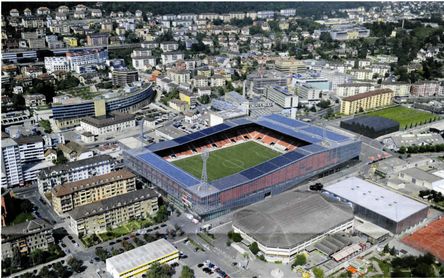
Dans le cadre du projet Holistic, Viteos a posé 4'113 m 2 de panneaux photovoltaïques sur le toit du stade de la Maladière. • Photo: Viteos
